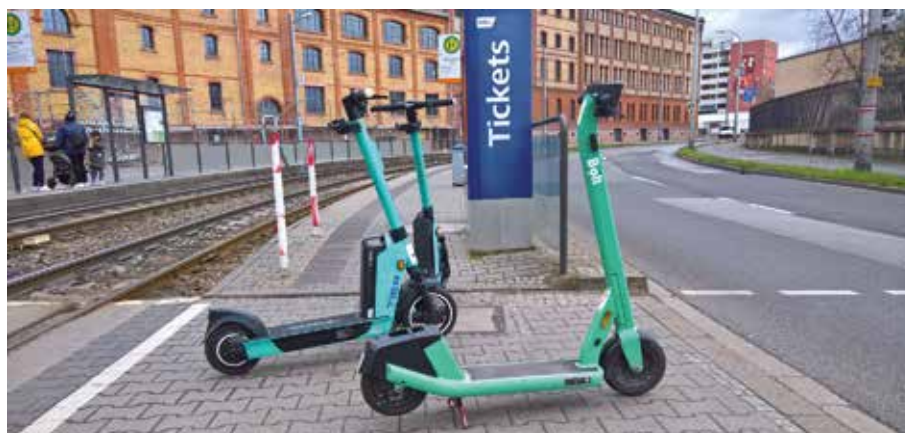
2 E-Scooter blockieren Auffindestreifen und Einstiegsfeld des Blindenleitsystems der Bushaltestelle Foto: AG Barrierefreiheit
